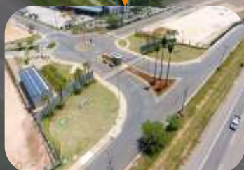
2 PORTARIAS BLINDADAS COM ACESSO DIRETO PARA RODOVIA SANTOS DUMONT
