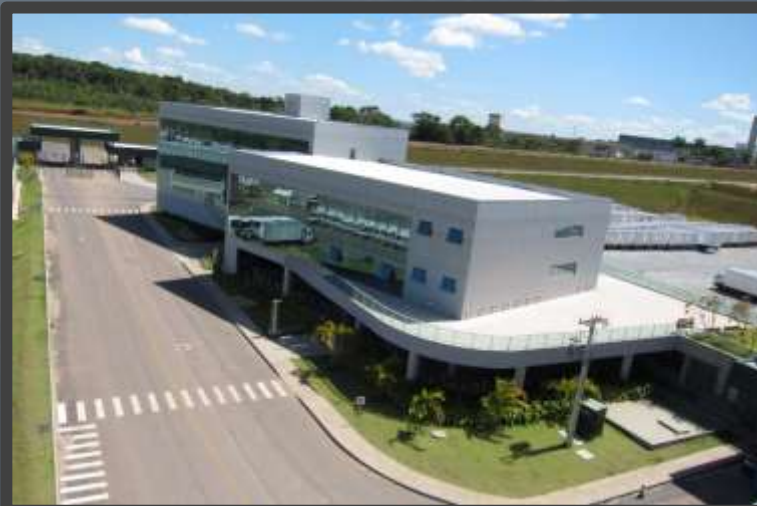
BRESCO CONTAGEM - ESCRITÓRIO OCUPAÇÃO A PARTIR DE 600m 2 CONTAGEM - MG
